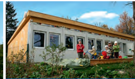
Kindergarten mit Pultdach
