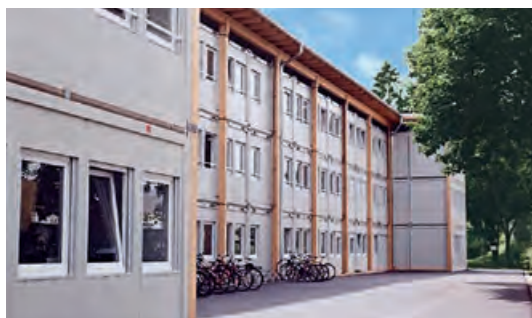
Schule dreistöckig mit Sekundärdach
