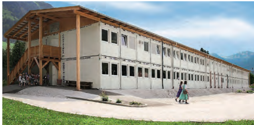
Schule zweistöckig mit Sekundärdach
